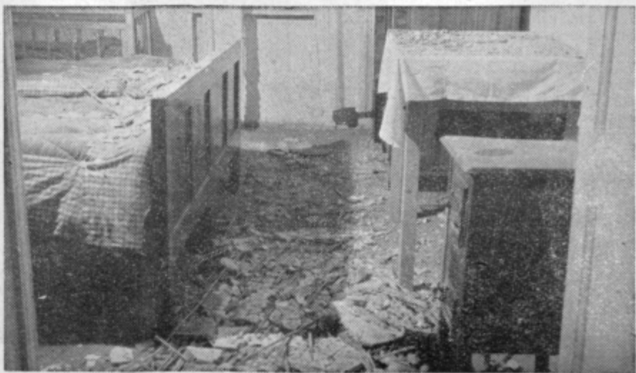
Takole je izgledala spalnica, ko se je vdrl strop.
