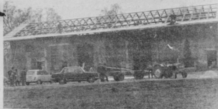
Se zadnja kleparska dela in dom občanov v Skorbi bo dobil streho
