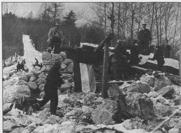
Gradnja skakalnic v Planici.
