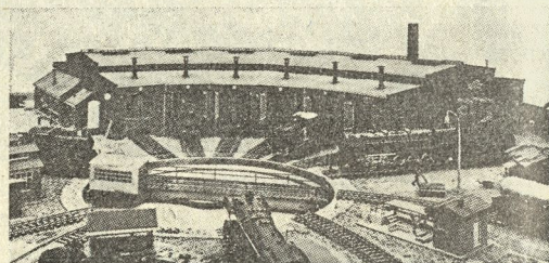
Slika 18: Obračališče za lokomotive
