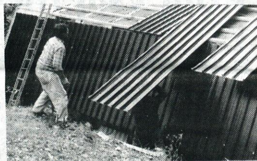
Nova streha nad Kulturnim domom na Močilniku.
