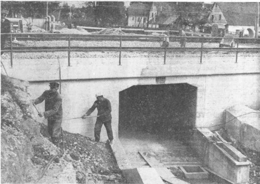
Delavci Železniškega gradbenega podjetja zaključujejo dela pri graditvi podhoda pod železniško progo na cesti Medvode—Preska (na fotografiji). Podhod bo imel dva metra široke stopnice za pešce in meter široko kolesarsko stezo. Računajo, da bo podhod že v novembru predan namenu.
