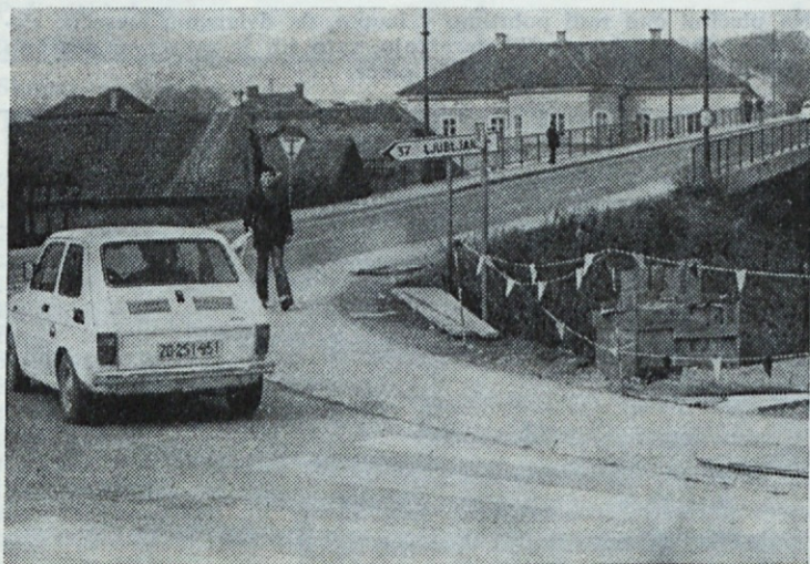
Novo litijsko križišče je med nadvozom in litijskim mostom še posebno nevarno. Gradbeni delavci so že izkopali temelje za postavitev semaforov, ki bodo uspešneje in varneje urejali promet na križišču.
