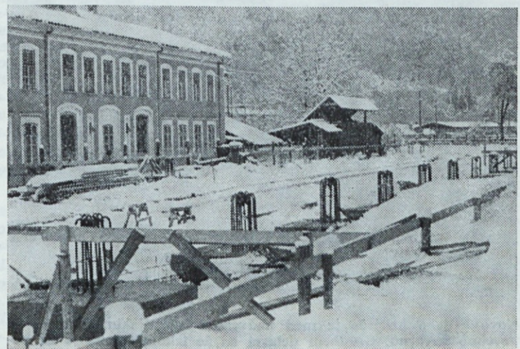
Sneg je le za kratek čas prekinil delo na gradbišču.
