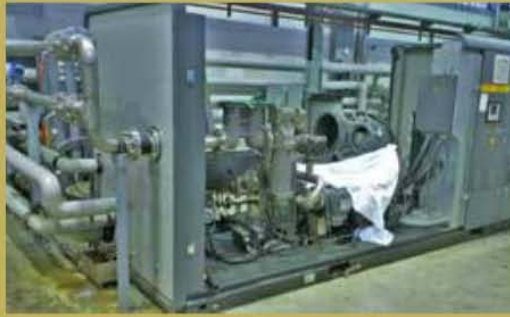
Fotografija 3: Remont kompresorja AC3
