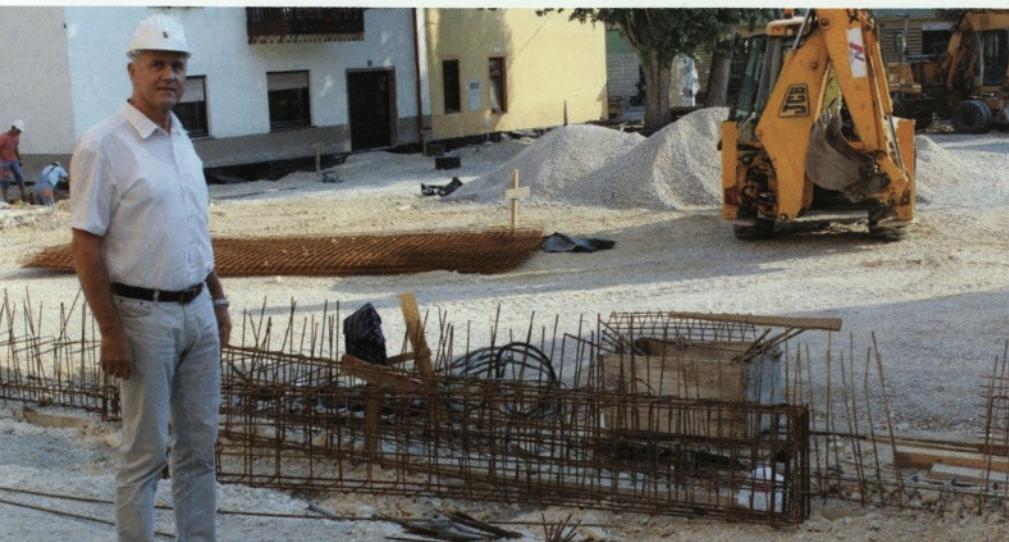
Viki Drev na gradbišču.
