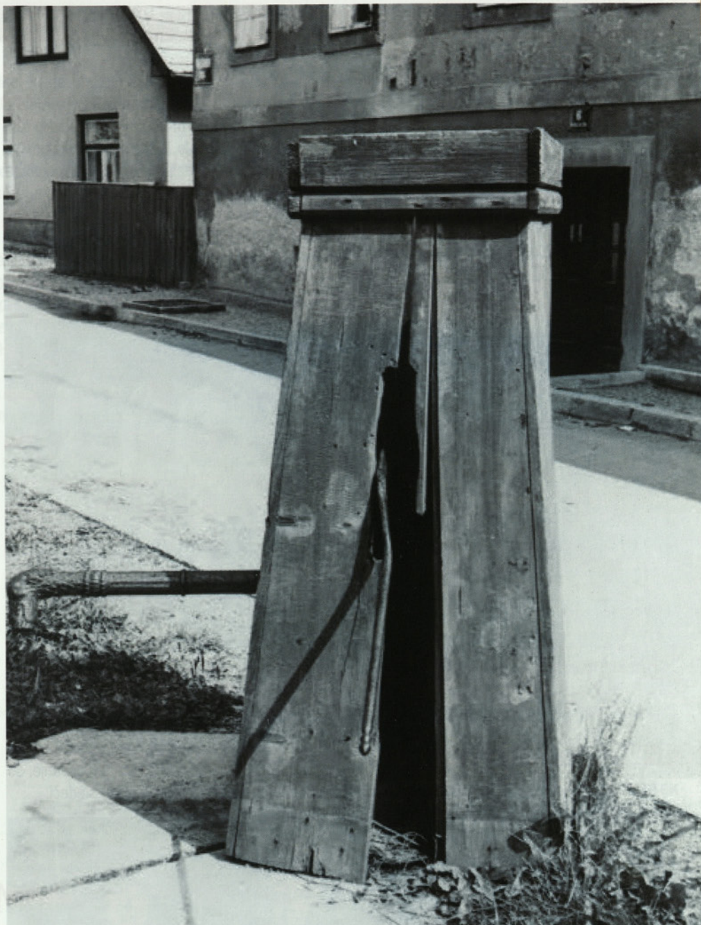
Nekdanji Totrov vodnjak. Skoraj vsi vodnjaki v centralnem delu mesta so bili zaprti in so delovali s pomočjo ročne črpalke. Foto iz arhiva Viktorja Kojc hrani Muzej Velenje.
