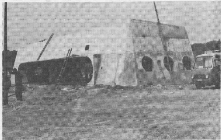
Vzporedno z gradnjo tovarne je bila zgrajena tudi trgovina.
