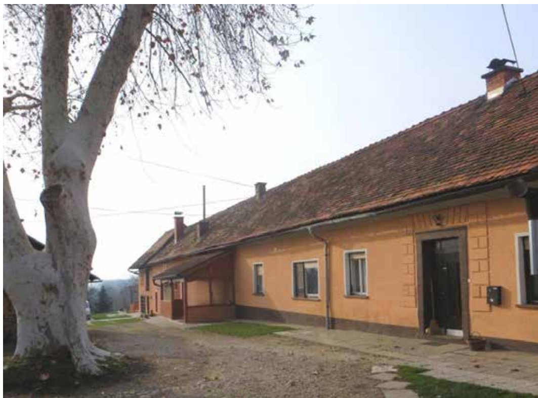
Zahodni trakt nekdanjega observantskega samostana manjših bratov služi danes kot stanovanjski objekt, posnetek s severovzhoda. Foto: Brane Lamut, december 2013.
