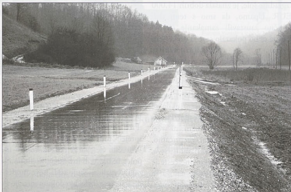
Cesta Zavrč–Drenovec je že skoraj obnovljena.
