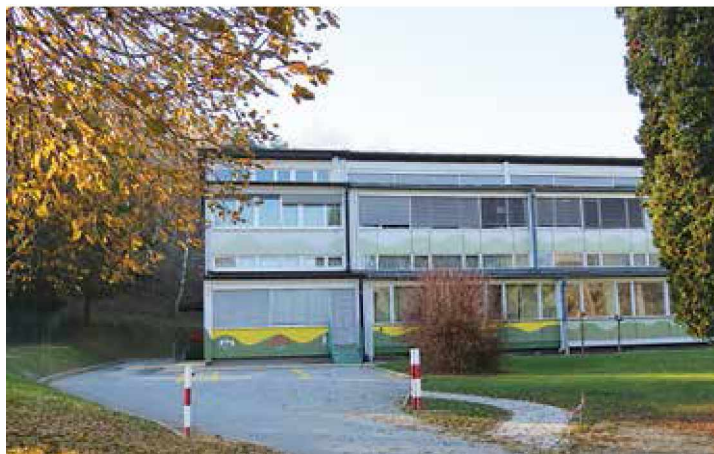
Dovoz in vhod v vrtec pri OŠ Grad (foto: D. Krpič)
