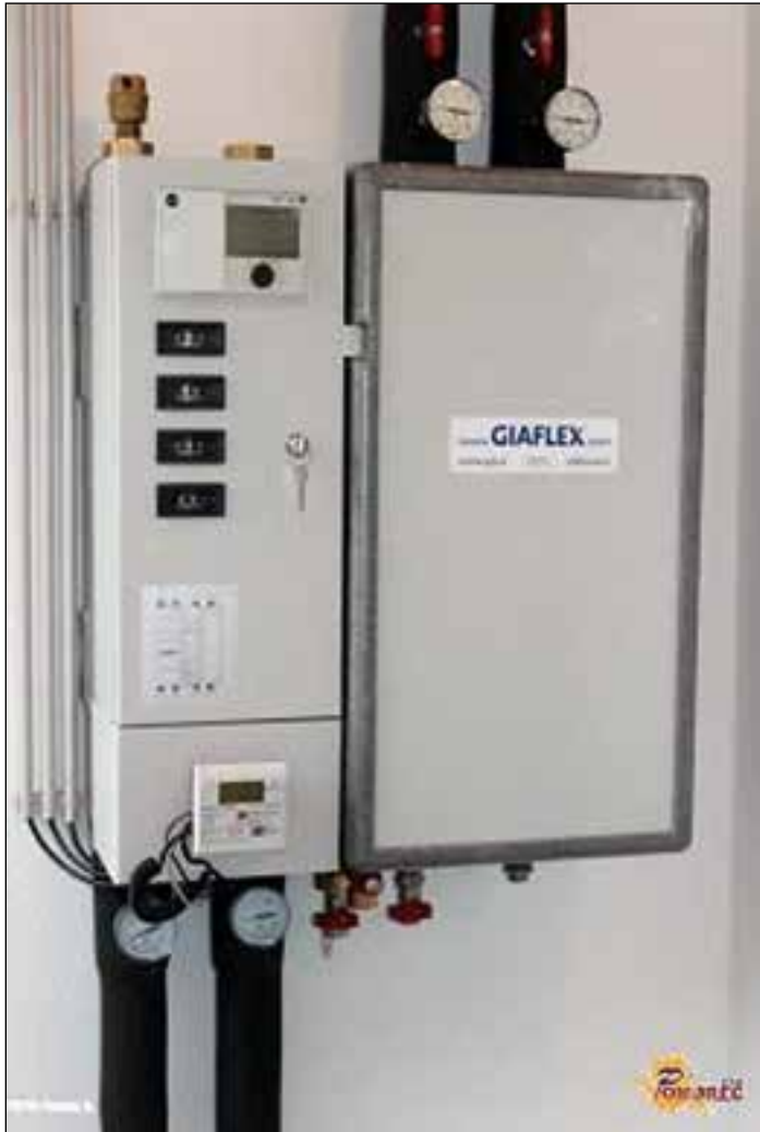
Primer inštalirane toplotne podpostaje za večjega porabnika toplotne energije
