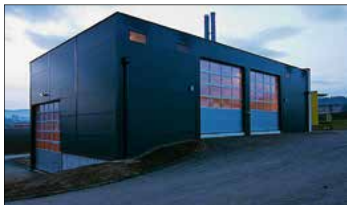
Sistem daljinskega ogrevanja na lesno biomaso Poelfing Brunn na avstrijskem Štajerskem, ki s toplotno energijo oskrbuje 52 objektov
