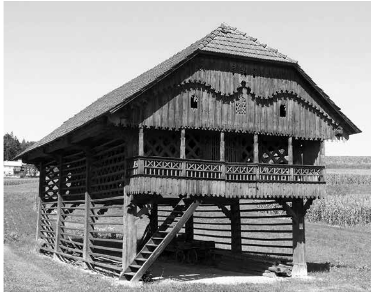
Prepoznaven Simončičev toplar pred obnovo
