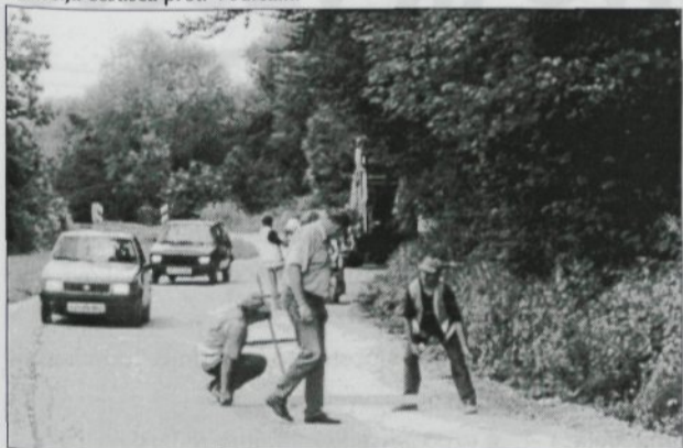
Sanacija cestišča proti Vodicam.
