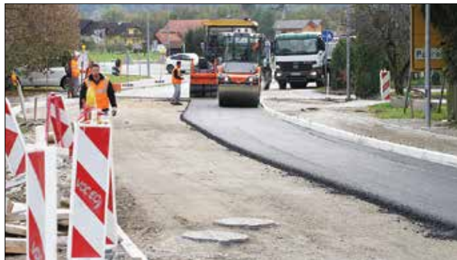
S polaganjem asfaltne prevleke se v teh dnevih zaključuje sanacija Šmihelske ceste. (Foto: Benjamin Kanjir)
