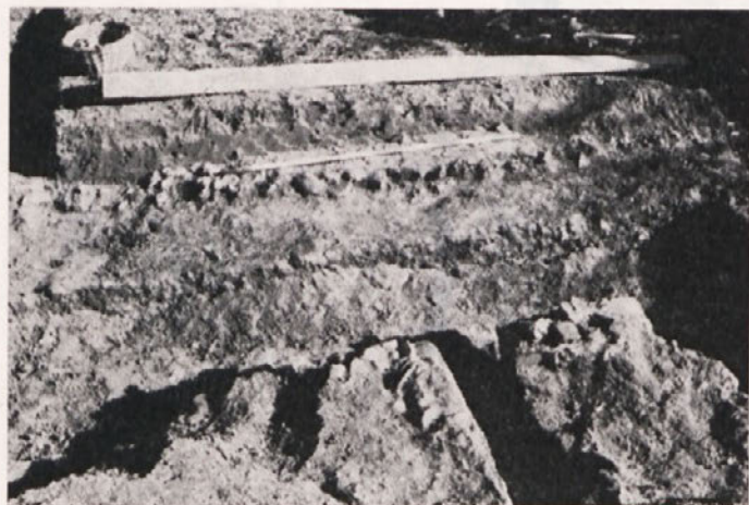
Pavlovci. Prostor 1 — pogled na estrih II (zgoraj) in estrih I (spodaj). Spredaj je viden del prostora 4 z ogrevalnim kanalom.
