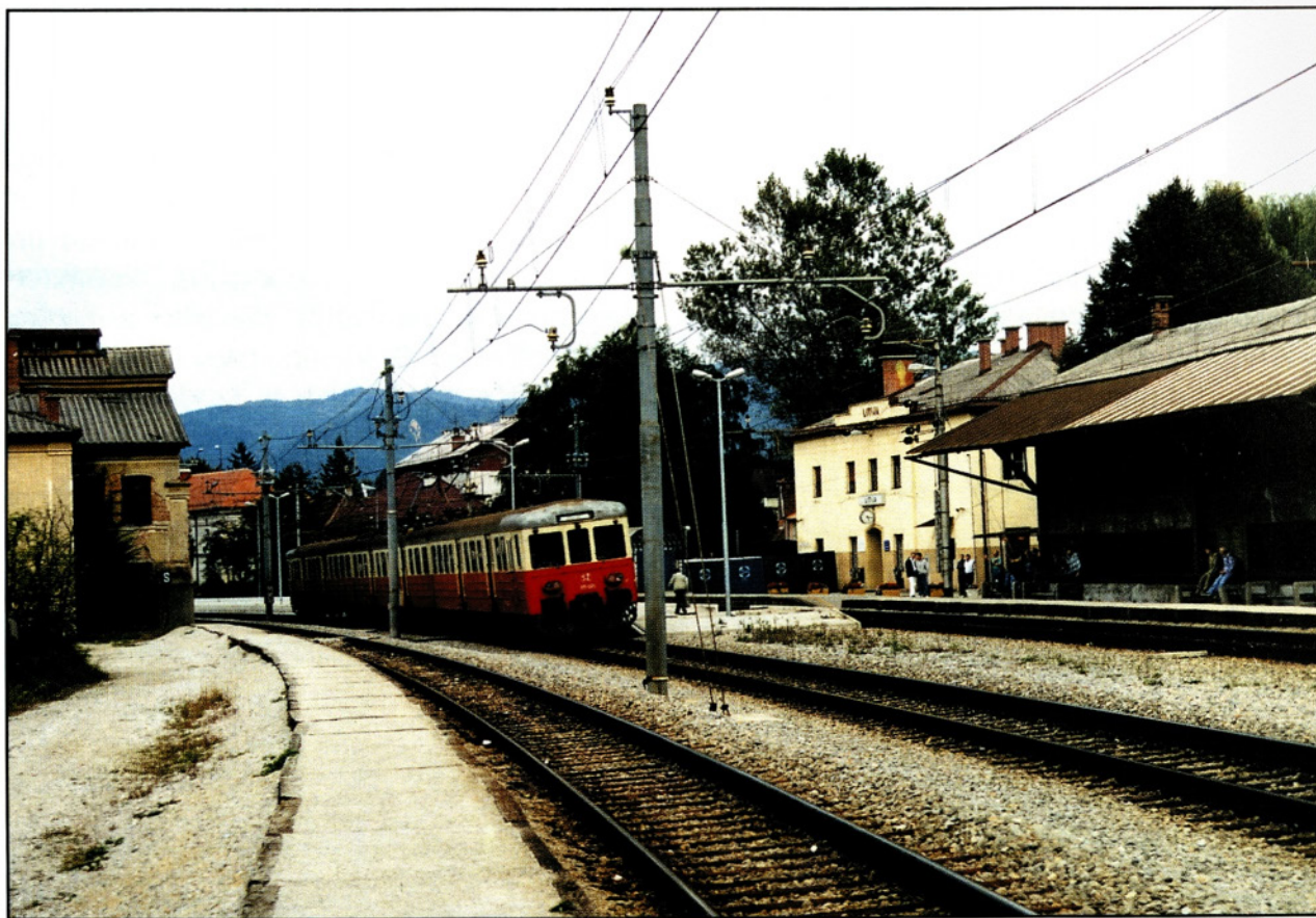
Litijska železniška postaja med rekonstrukcijo, leta 1997 (foto: M. Brilej).
