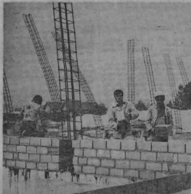
S sredstvi iz drugega samopriskevka bo zrasel ob Dečkovi ulici vzgojni zavod Janeza Levca. Gradi ga SGP Graditelj iz Kamnika. Objekt bo dograjen maja prihodnjega leta.
