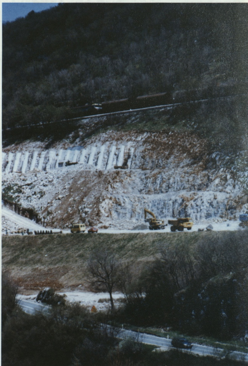
Slika 3: Sidrane brežine pod železniško progo. Foto: Ž. Babič, DDC
