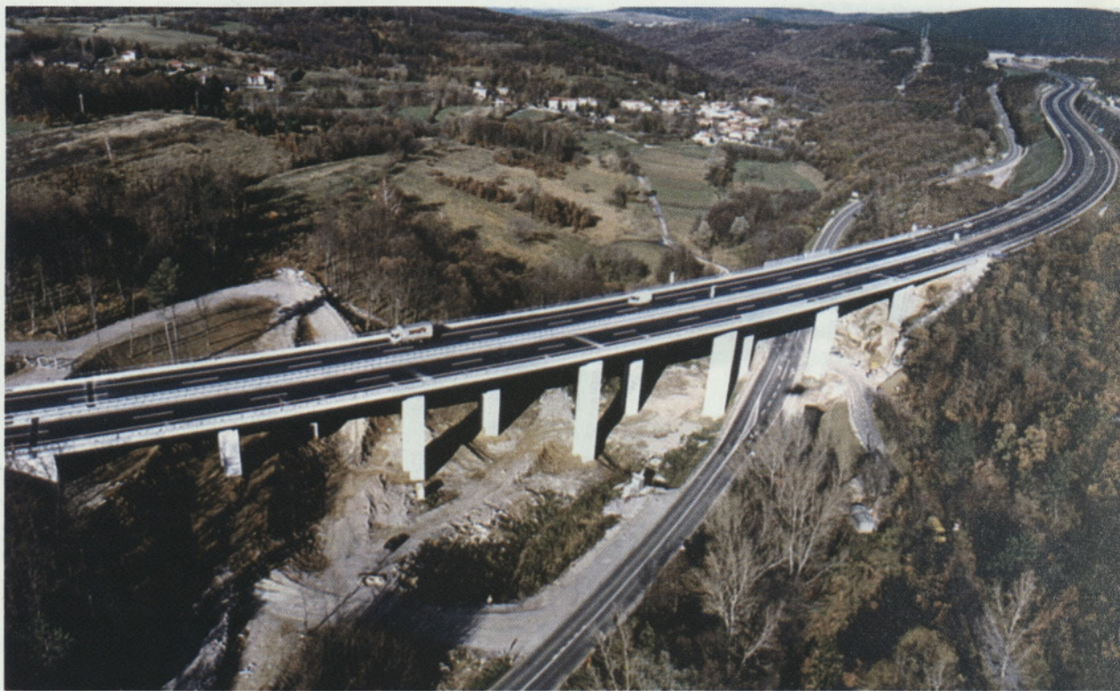
Slika 6: Viadukt 6-2 Glinščica. Foto: F. Hrvatin, DDC
