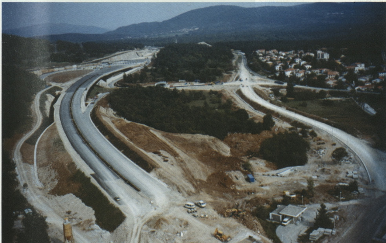
Slika 2: Trasa s cestninsko postajo, priključkom Kozina in deviacijo glavne ceste med gradnjo. Foto F. Hrvatin, DDC
