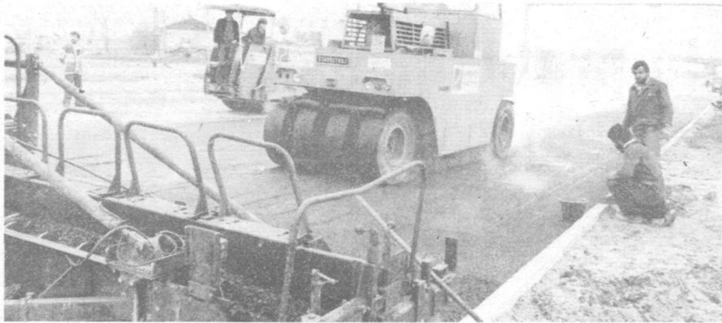
Prekrivanje asfaltne prevleke v zadnjih dneh oktobra
