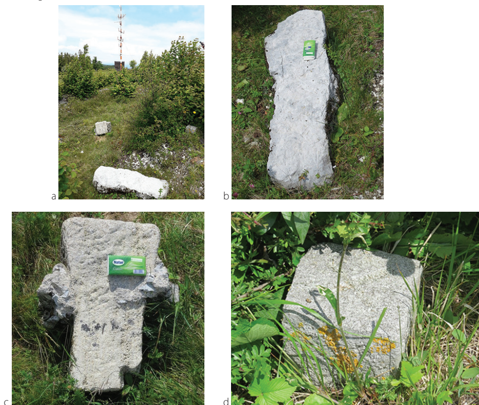
Slika 2: Višinska kota 999 m na Županovem vrhu nad Rakitno: a) desno vkopan granitni kamen iz povojne izmere, spredaj izkopan apnenčasti kamen, najverjetneje iz obdobja 1818–1819, in levo zgornji del betonskega kamna iz let 1902–1903, b) ločeno apnenčasta klada s papirnati robčki za merilo, c) betonski kamen in d) granitni kamen z vklesanim križem na vrhu (foto: M. Triglav Čekada, 2020).
