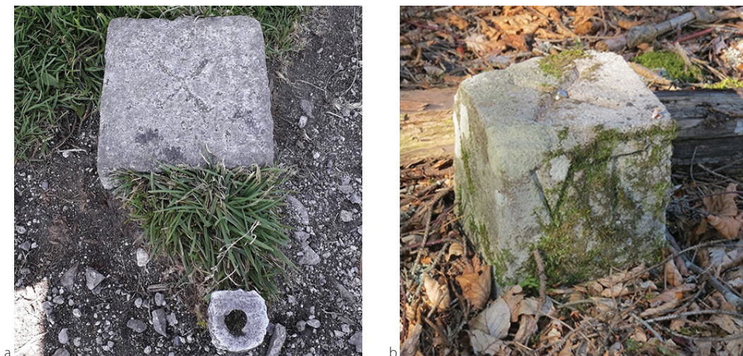
Slika 9: a) primer stabilizacije GZS Lajnar IV. reda (foto: M. Triglav Čekada, 2020) ter b) primer stabilizacije GJUNA Jašč Vrh nad Koprivnikom v Bohinju točka III. reda 32 Jesenice z napisom VT – vojna triangulacija (foto: M. Triglav Čekada, 2020).
