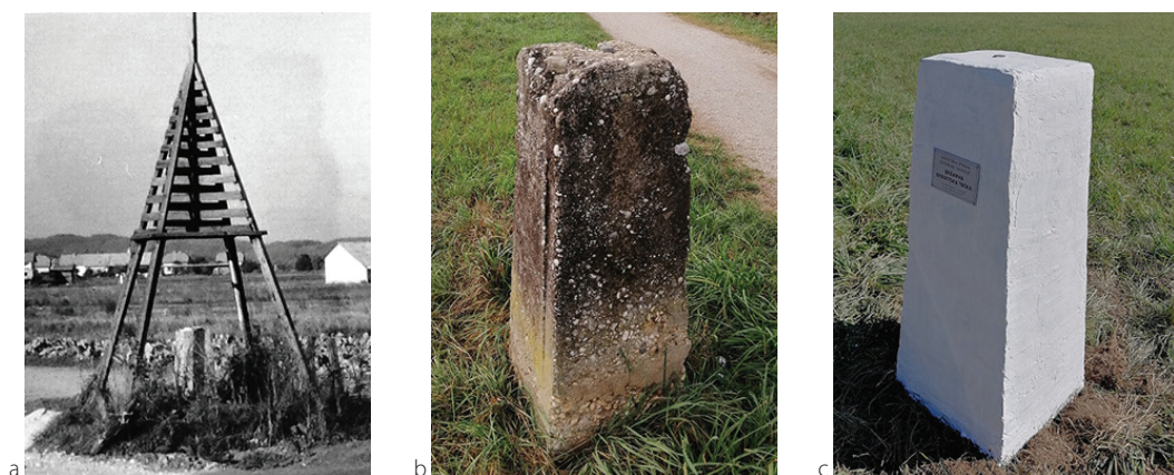
Slika 21: Ljubljanska triangulacijska baza: a) zahodna bazna točka 551, fotografirana leta 1962, na njej je originalna lesena piramida iz leta 1955 (steber je bil kasneje odstranjen, zemljišče pa zazidano) (foto: Jenko), ter vzhodna bazna točka 550, fotografirana septembra 2020, pred b) in po obnovi 6 c) (K. Medved).
