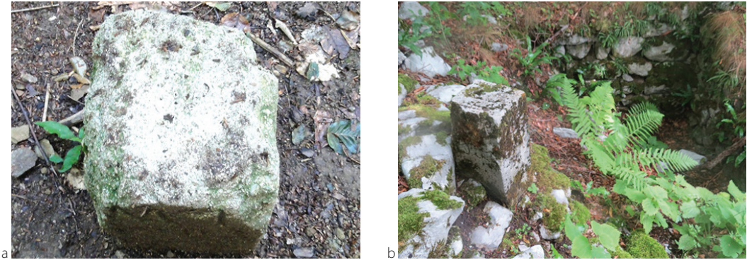
Slika 3: a) Točka II. reda 120z Gradišče nad Podsmreko: na sliki je na spodnji stranici še vidna oznaka MT – Militärische Triangulation (foto: S. Tršan, 2020) in b) točka II. reda 329 Limberk, ki je zabetonirana na ostanke stare pozidave (foto: M. Triglav Čekada, 2020).
