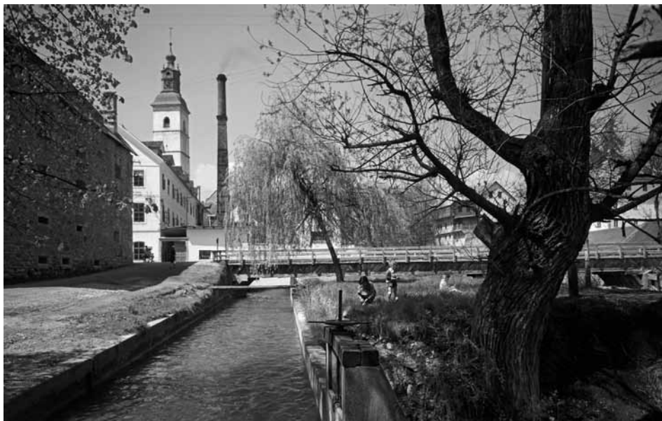
Mlinske rake ob nekdanji gosposčinski kašči in Lahovem mostu.
