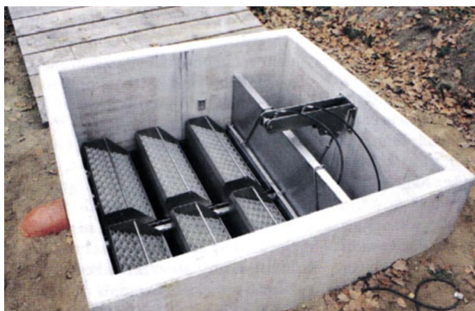
Slika 12 • Dve fazi inštalacije opreme (brez odtočnih korit in z njimi)
