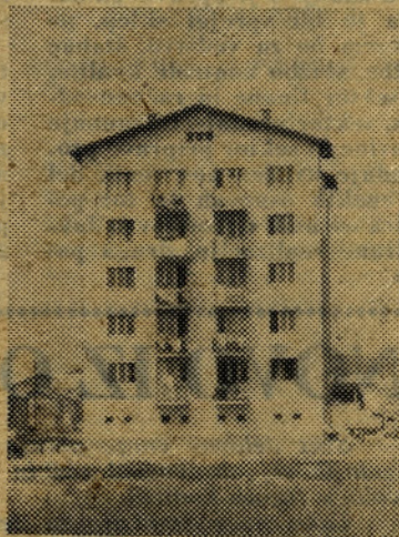
Lani smo zgradili 2 stolpica ...
