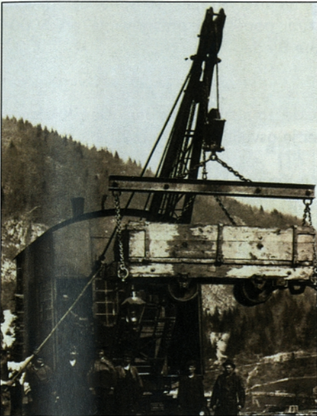
Izkopano iz predora so izsipali iz vagončkov s parnim dvigalom (zbirka Tomaža Budkoviča)
