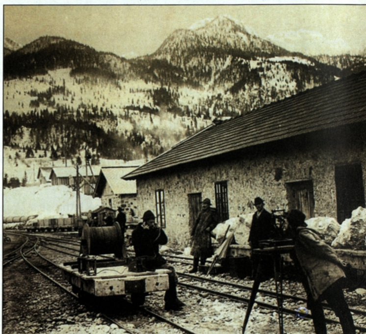
Gradnjo predora so kontrolirali z natančnimi geodetskimi meritvami; potekale so med prazniki, ko je drugo delo v predoru počivalo
