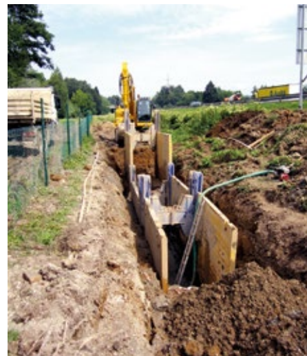
Gradnja kanalizacije ob avtocesti
