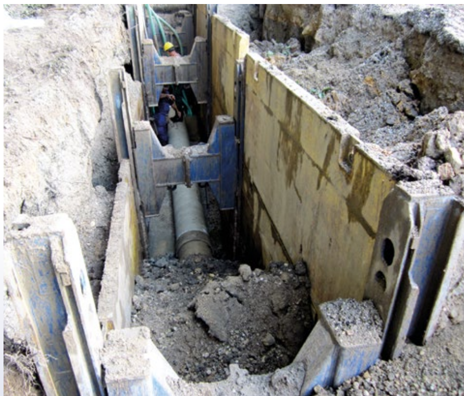
Gradnja kanalizacije v Povodju
