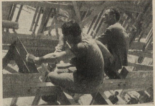
Notranjost nove toplarne
