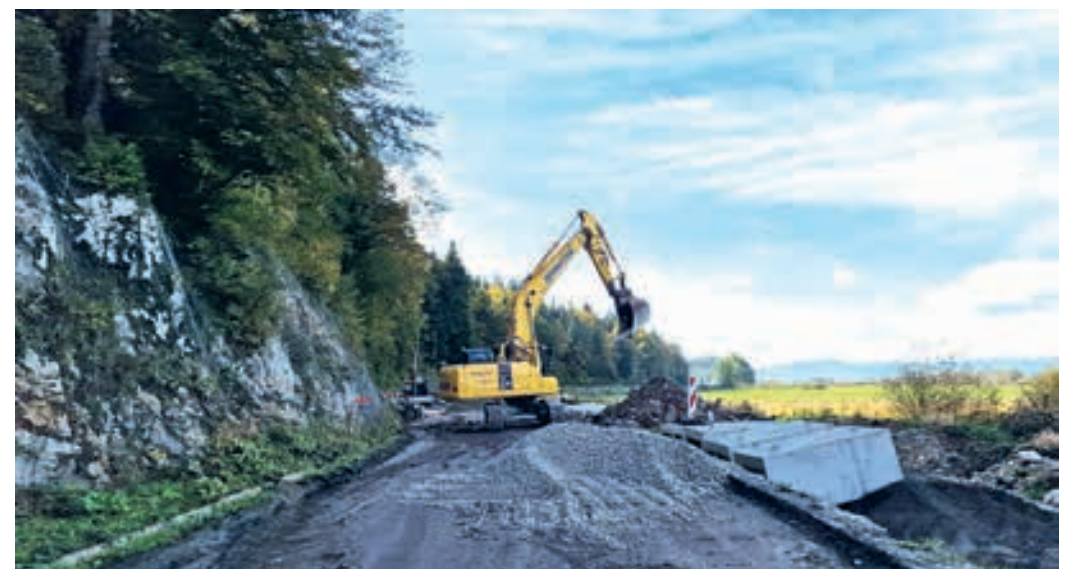
Vgradnja podhodov pri Podkraju je v zaključni fazi.
