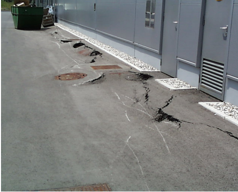
Slika 6: Lomljenje asfaltnih površin.
