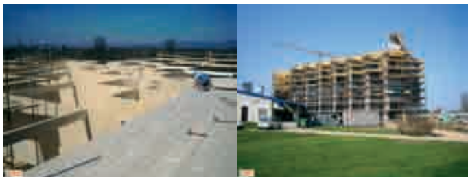
Slika 13: Nadgradnja hotela Terme Čatež izvedena v masivni leseni križno lepljeni konstrukciji.
