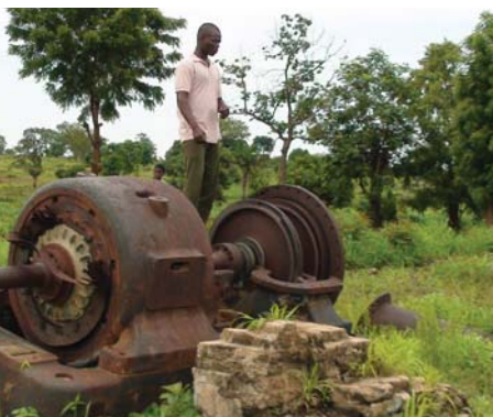
Slika 3: Ostanke generatorja in turbine
