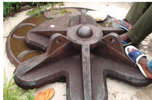
Slika 2: Jeklene podstavke nosilnega stebra antene.
