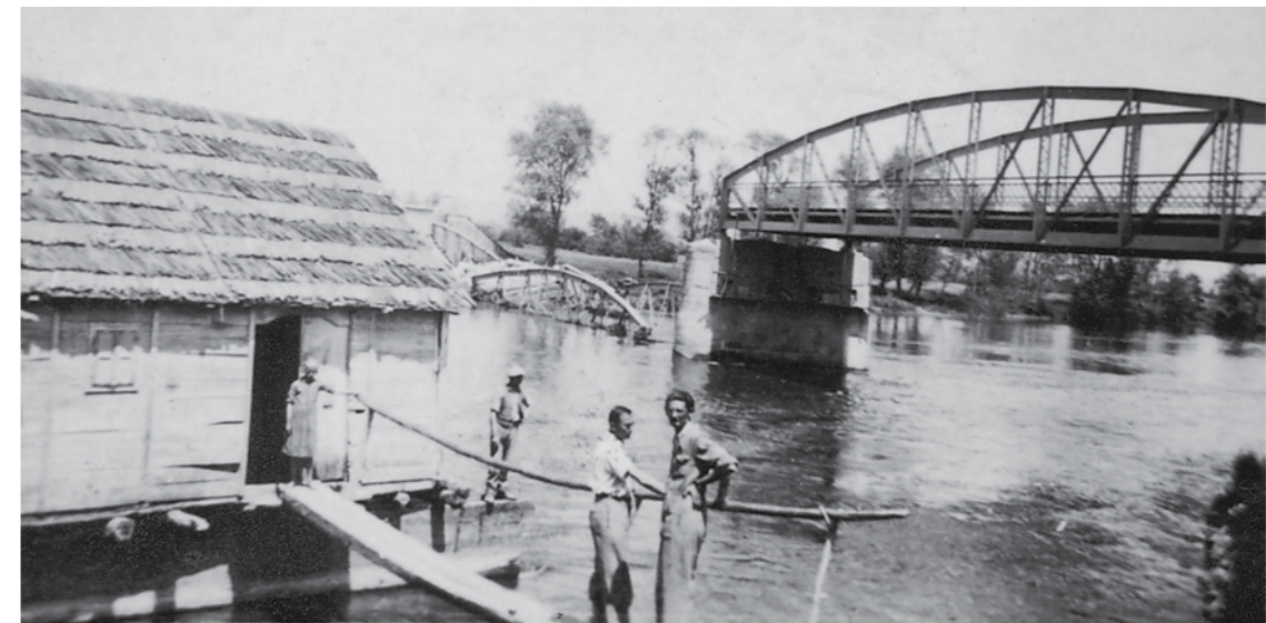
Porušen željeznički most uz mlin na rijeci Muri, 1941.
