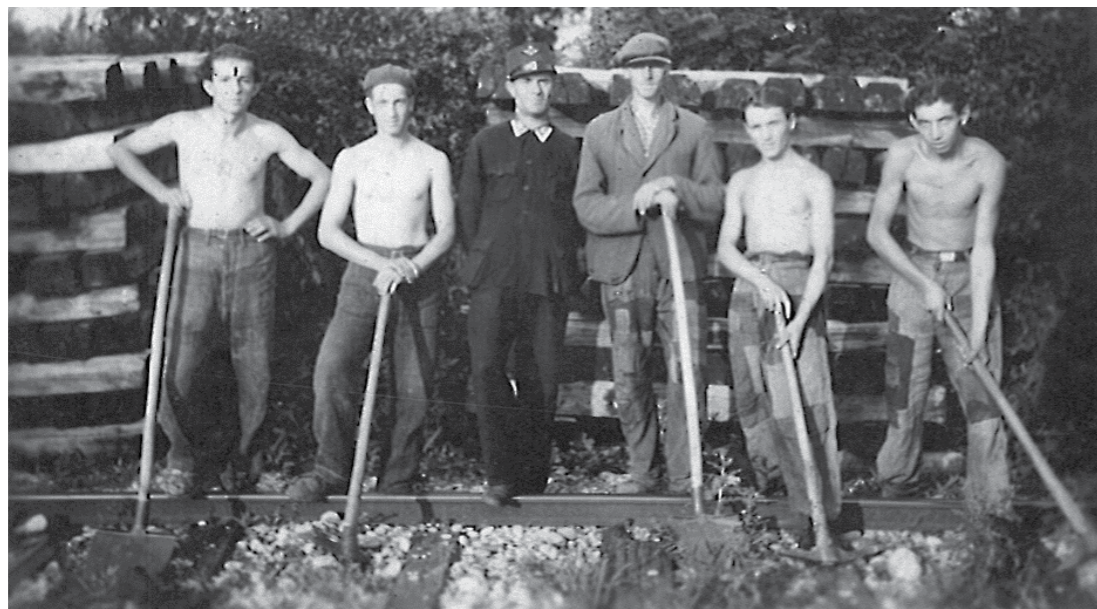
Zamjena željezničkih pragova na pruži u Murskom Središču, potkraj Drugog svjetskog rata
