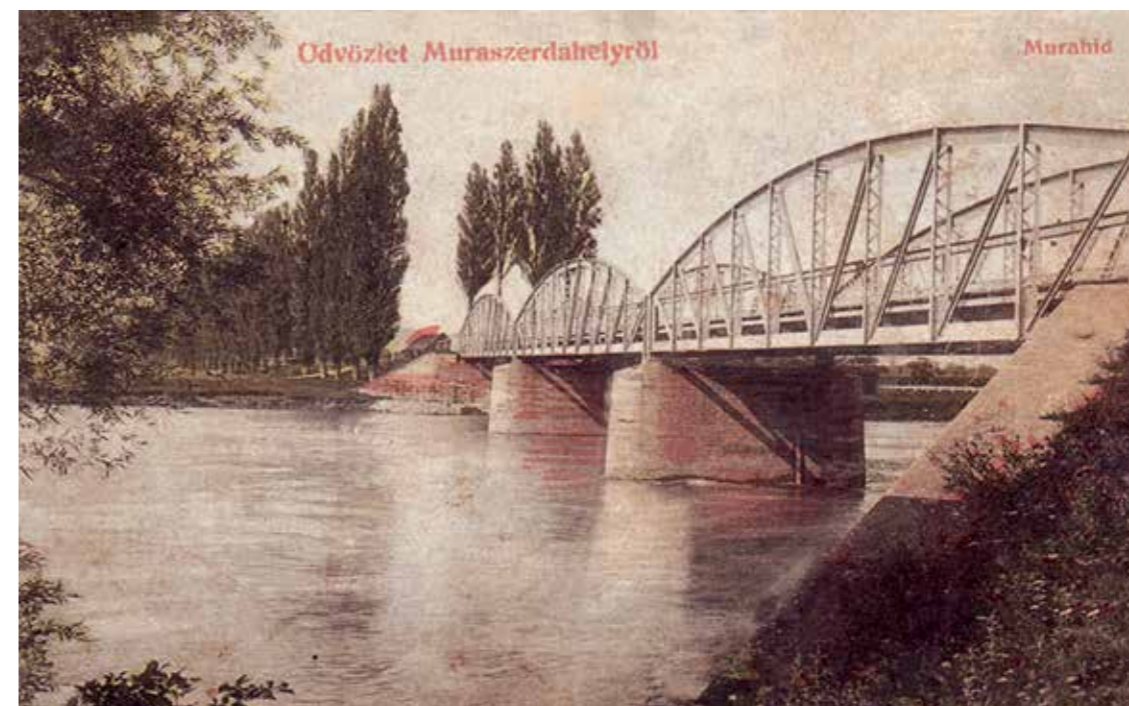
Željeznički most preko Mure u Murskom Središču, prva polovica 20. st.
