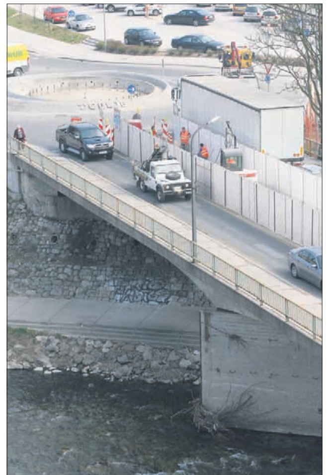
Most čez Savinjo – lotila se ga je direkcija za ceste
