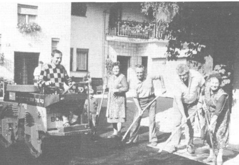
Asfaltiranje zadnjega dvorišča
