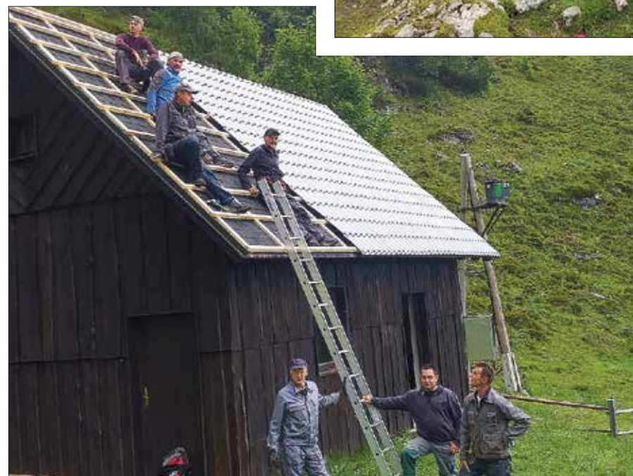
V delovni akciji so prekrili streho na pomožnem objektu - zimski sobi.
