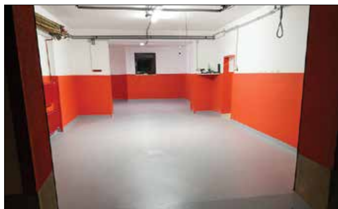
Po vseh garažah so naredili epoksi tlake.
