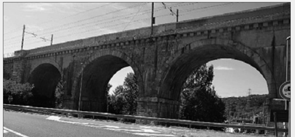
Železniški most pri Sabličih
