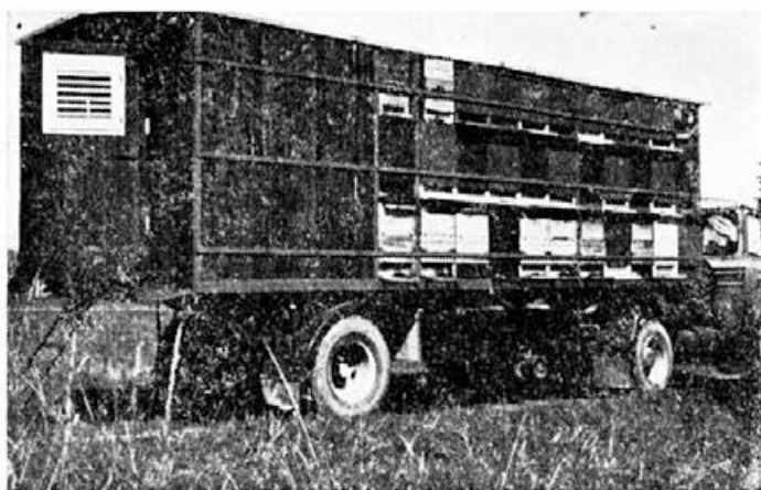
Prikolica vlačilca predelana v prevozni čebelnjak s posebnim delovnim prostorom
