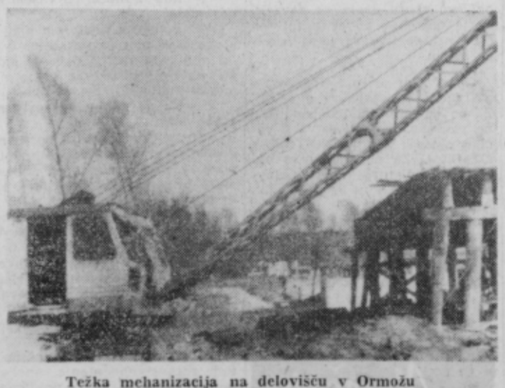
Težka mehanizacija na delovišču v Ormožu
