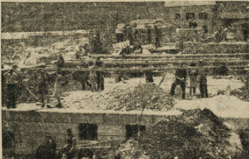
Gradilišče v Zidanem mostu na dan 27. aprila
