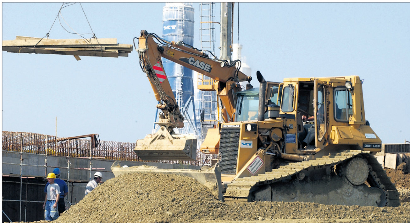
Gradnja avtocestnega odseka Cogetinci–Vučja vas
