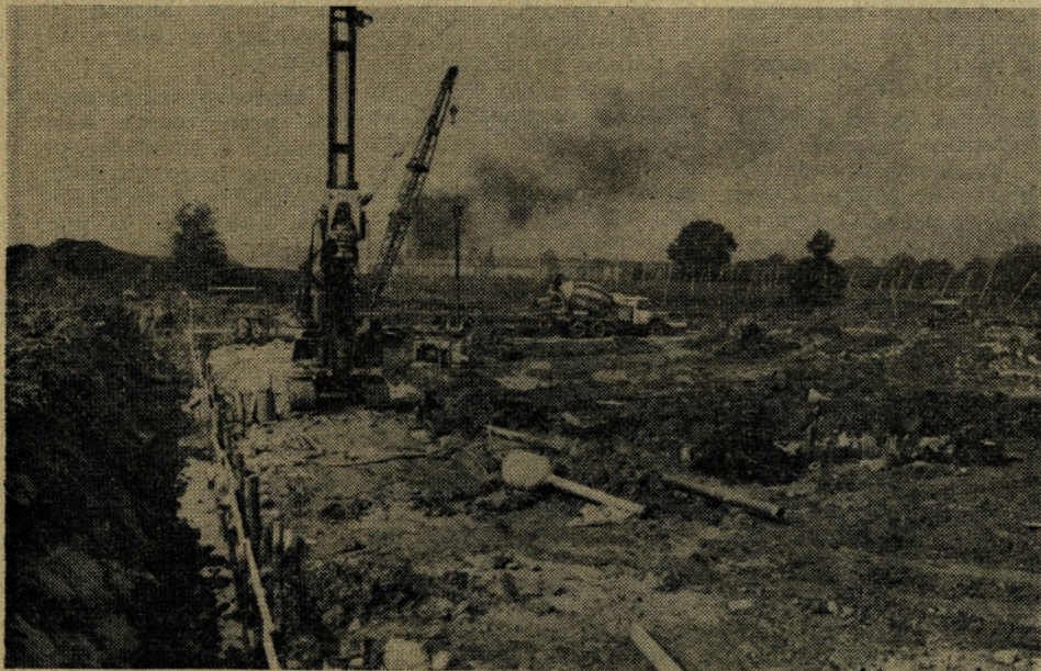
Zemljska dela v Šentjurju so pri kraju. Začetek gradnje treh dvoran se je pričel.
