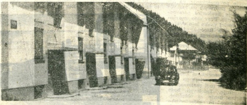
Prebivalci ob Delavski cesti v Stražišču upravičeno upajo, da bo že letos konec prahu in lukenj pred njihovimi hišami
