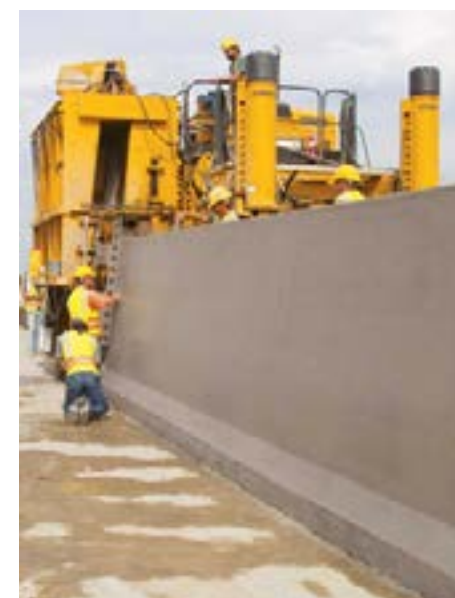
Slika 9: Primera slip-forming gradnje betonske varnostne ograje, pridobljeno z: https://www.gomaco.com/resources/commander_4t_barrier.html
