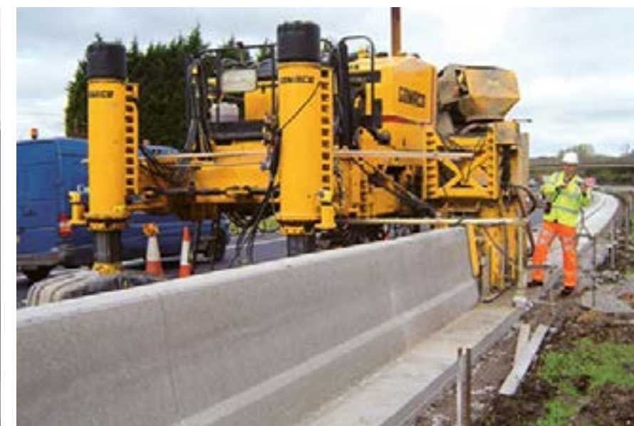
Slika 9: Primera slip-forming gradnje betonske varnostne ograje, pridobljeno z: https://www.gomaco.com/resources/commander_4t_barrier.html
