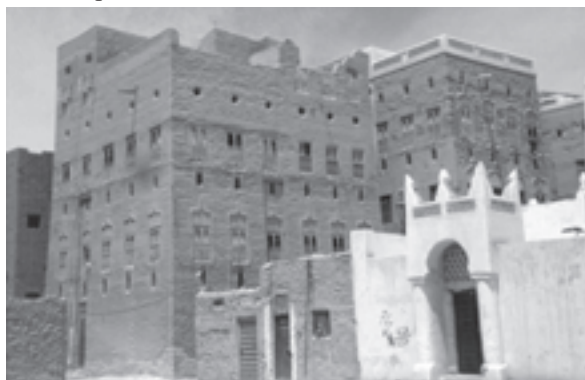
Slika 11: Stene iz ilovnatih zidakov. (Foto: B. Juvanec) Walls made of clay bricks.
