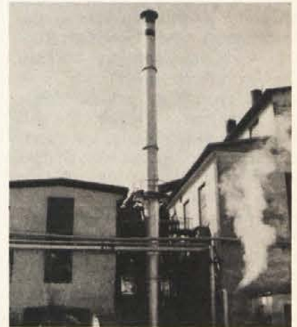
V sredini vidimo na novo vgrajeni elektrofilter tovarne „Obir“
