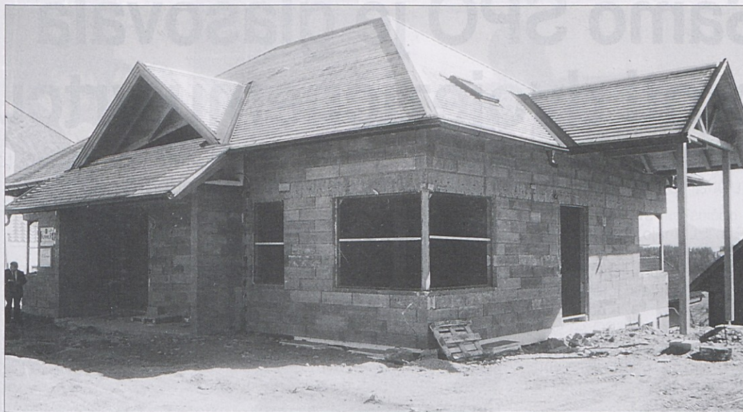
Na Djekšah bodo kmalu odprli novi občinski urad, ki ga gradijo v neposredni bližini starega, ki pa je že v zelo slabem stanju. Novi urad bo izredno lep in bo nudil uradnikom tudi boljše razmere za delo.
