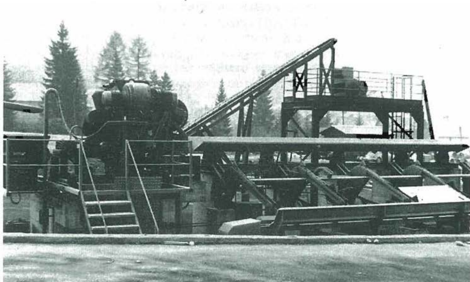
Sl. 3 Mlin za lubje, postavljen na odru na koncu transporterja, ki odnaša lubje od lupilnega stroja, na centralnem mehaniziranem skladišču v Bohinjski Bistrici (foto ing. Remec)
