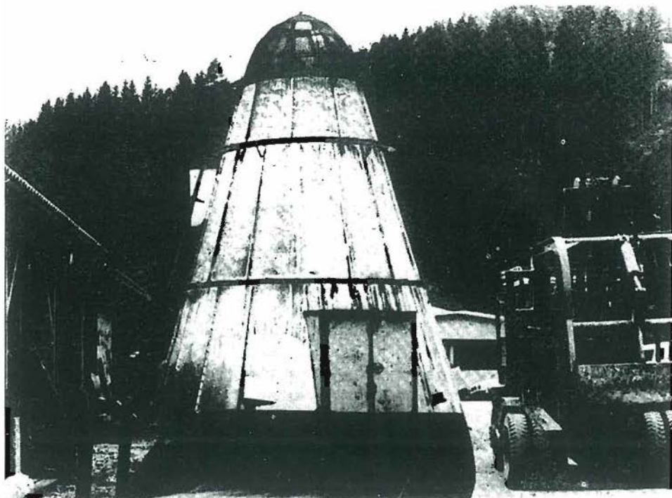
Sl. 1 »Rees« peč za sežiganje lubja na žagarskem obratu v Železni Kaplji (na avstr. Koroškem)
