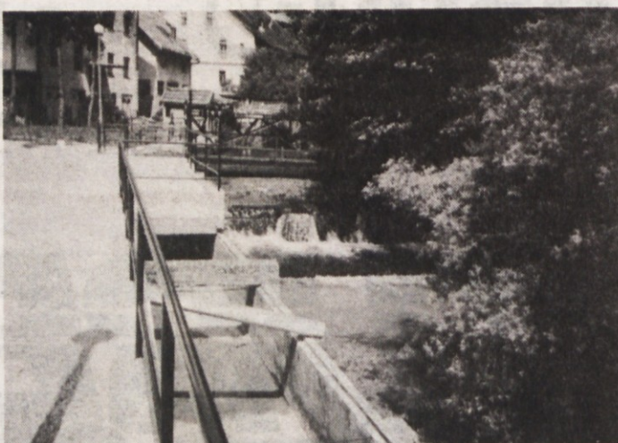
KANAL DO MALE ELEKTRARNE V ČABRU - Kanal, ki vodi ob strugi Čabranke do male elektrarne v Čabru, je bil tistega dne (30. junija) suh, ker mala elektrarna ni delala in torej niso odzvali vode iz Čabranke. Pretok vode v strugi Čabranke je bil normalen. Sicer pa ta elektrarna za življenjsko potrebo ni more biti usodna, saj je od jezusa pa do elektrarne le dobrih 50 m in bi bilo ob neodgovornem početju v sušnem obdobju suhe struge le dobrih 50 m.
